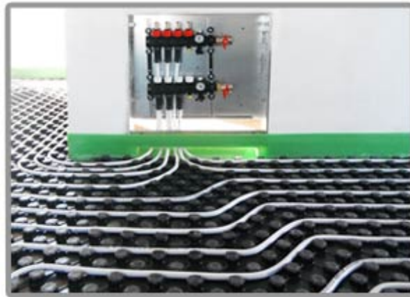
(Esempio del sistema a pavimento radiante proposto)
